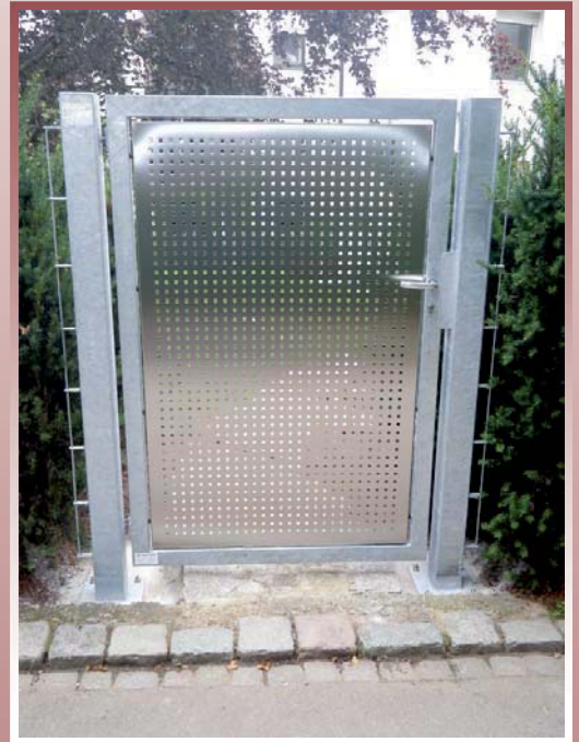
Stahltür mit Edelstahllochplattenfüllung
