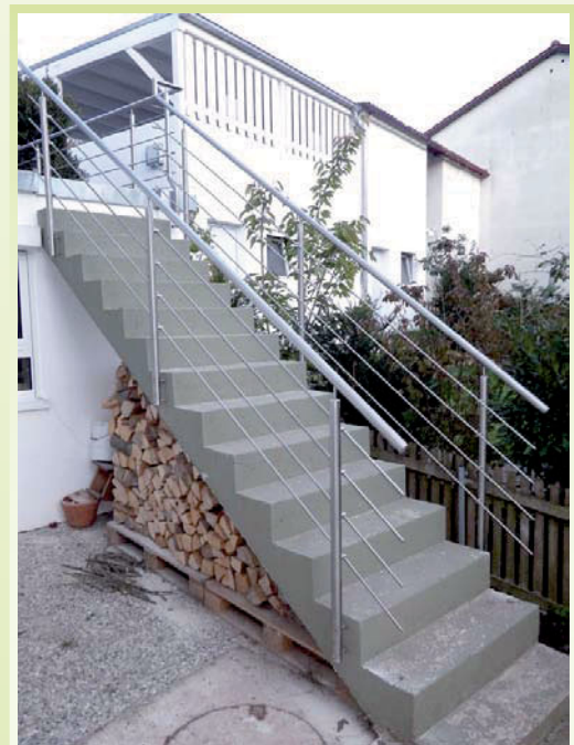
Treppengeländer aus Edelstahl mit Edelstahlstabfüllung
