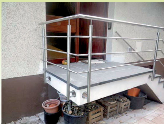
Treppengeländer aus Edelstahl mit Edelstahlstabfüllung
