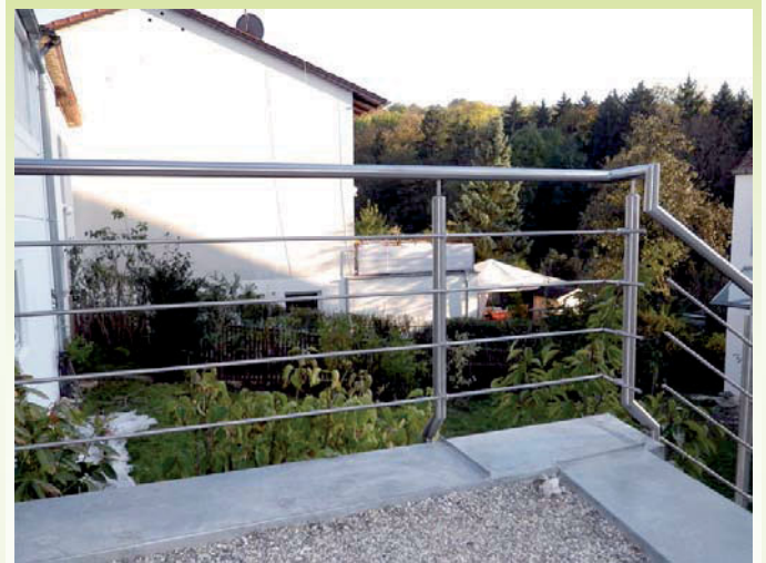
Terrassengeländer aus Edelstahl mit Edelstahlstabfüllung
